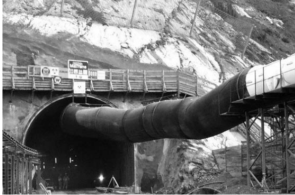
Նկ. 26. Ստորգետնյա փորվածքի օդափոխություն
