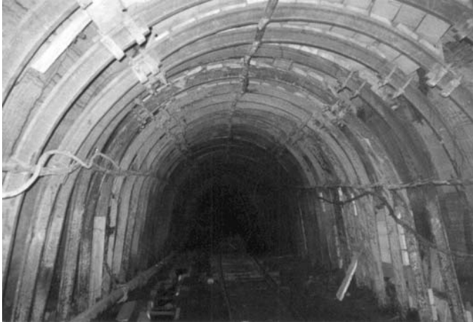
Նկ. 24. Համակցված ամրակապիչներ՝ մետաղյա կոնստրուկցիա և երկաթբետոնե սյուներ
